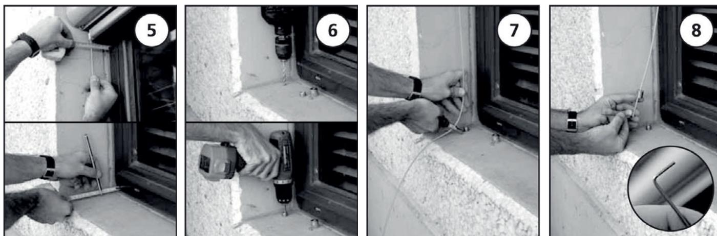
**5, 6 :** Une fois le coffre fixé, prendre la distance entre la fenêtre et le câble tendu, et reporter cette distance sur le rebord de la fenêtre puis fixer les tendeurs de guidage des câbles.
