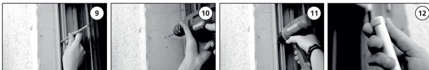
9, 10, 11 : Marquez l'emplacement des fixations des coulisses. Retirer le store et percer aux endroits marqués. Remettre le store en place et visser les coulisses au mur (Au moins deux vis de chaque côté).
