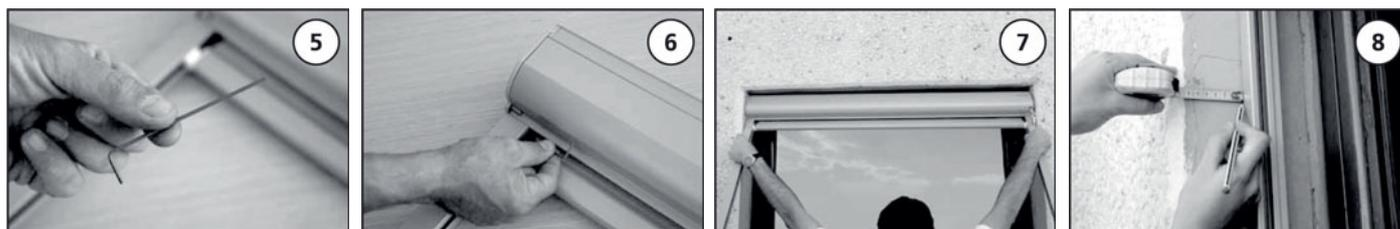
5, 6 : Positionner les différents éléments comme sur l'image 1. Ensuite, insérer l'embout d'extrémité dans la coulisse puis emboîter la coulisse sur le coffre jusqu'à entendre un «Click».
