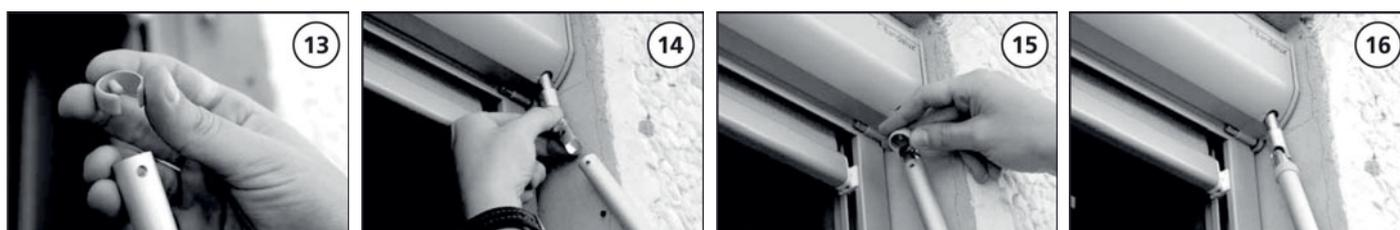
14, 15, 16 : Insérer la tulipe dans le tube de la manivelle et remettre le goupille.
